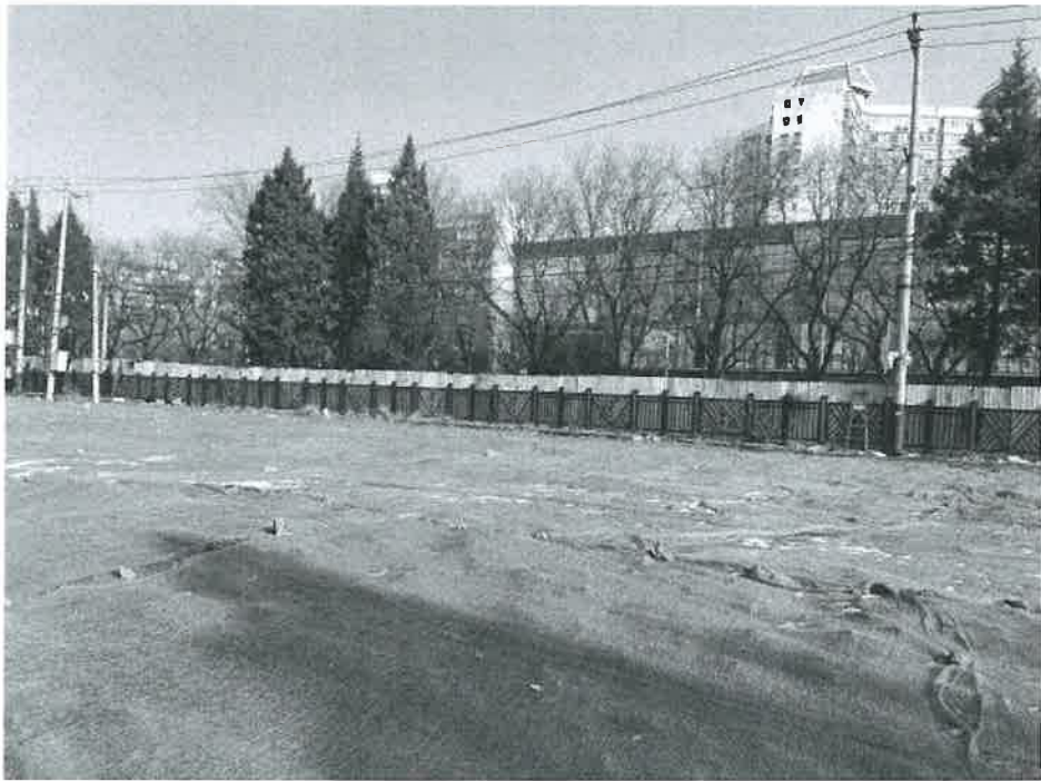
图 2-4 建设项目地块现状图
